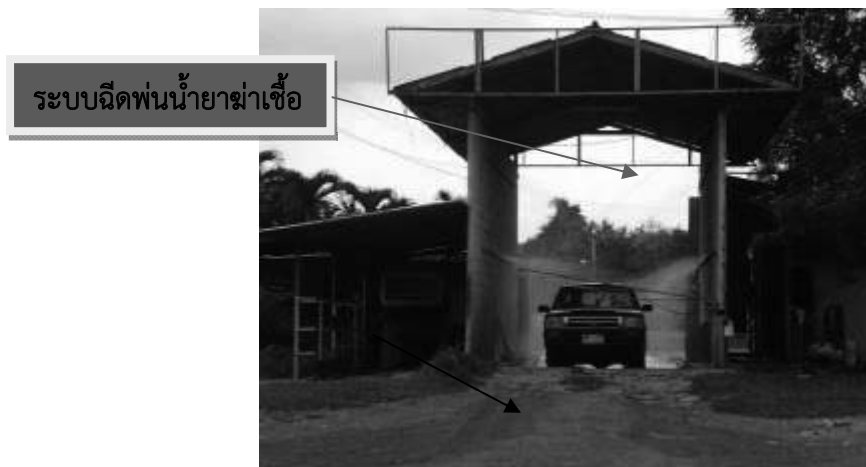
รูปที่ 6.2-4 การฉีดพ่นน้ำยาฆ่าเชื้อรถยนต์พาหนะที่เข้าภายในฟาร์ม
