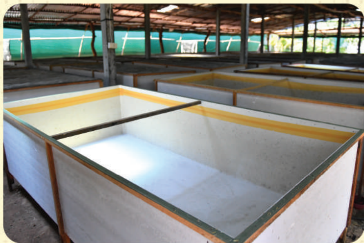
ยิบซั่มบอร์ด ทำความสะอาดง่าย วัสดุน้ำหนักเบา ก่อสร้างง่าย
